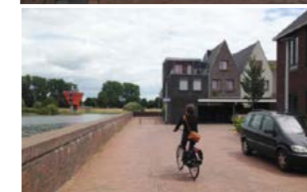
Rijbaan gebakken klinkers met voetgangersstrook
