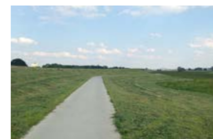
Voetpad beton langs het water
