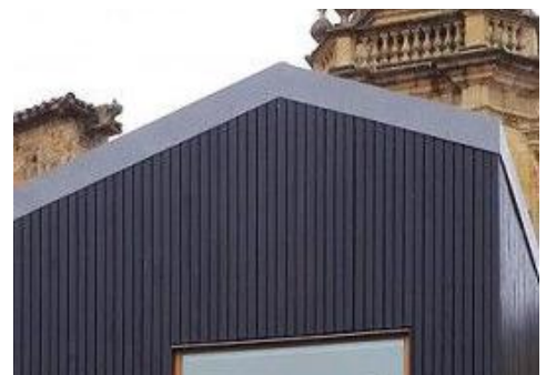
Als alternatief kunnen dakranden juist worden aangezet. De rand wordt een eigen vlak of ornament dat laat zien van welk materiaal het is gemaakt. De dakrand ligt in dit geval ook vlak in de gevel
